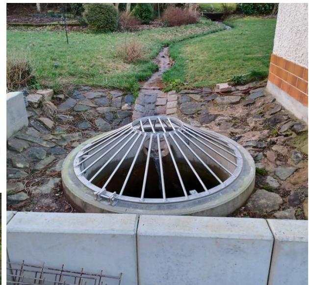
Abbildung 36: Grabensystem und Einlaufbauwerk
