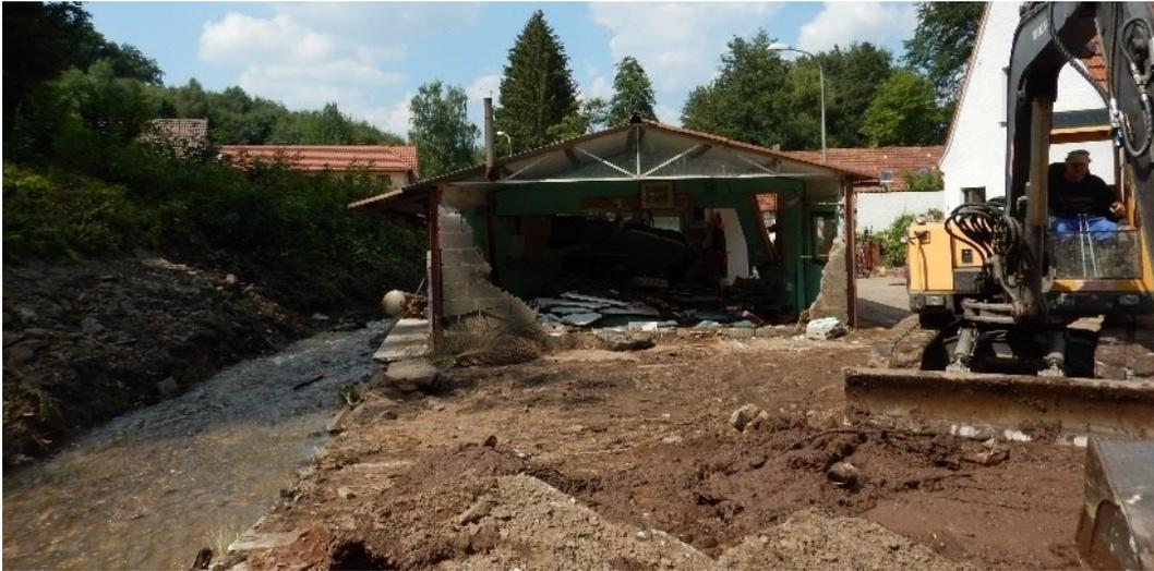
Abbildung 53: Eingestürzte Wand infolge Wasserdrucks (Beispielbild)
