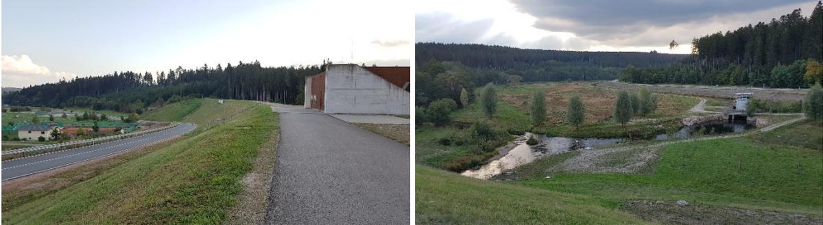
Abbildung 54: Beispiel Hochwasserrückhaltebecken Wolterdingen im Donau-Einzugsgebiet (max. Dammhöhe 18 m, Stauraum 4,7 Mio. m<sup>3</sup>, Bemessung auf ein 100-jährliches Hochwasser)
