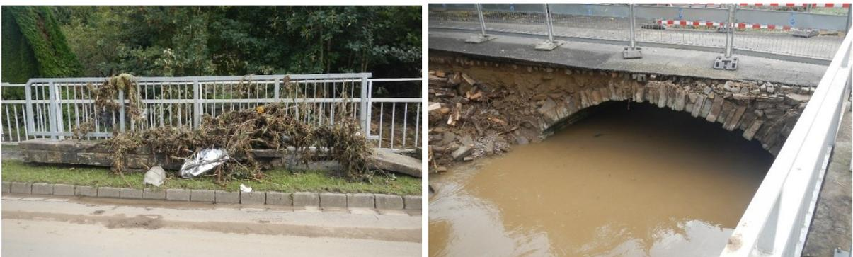
Abbildung 52: Treibgut und zerstörtes Brückengeländer infolge Wasserdrucks (Beispielbilder)
